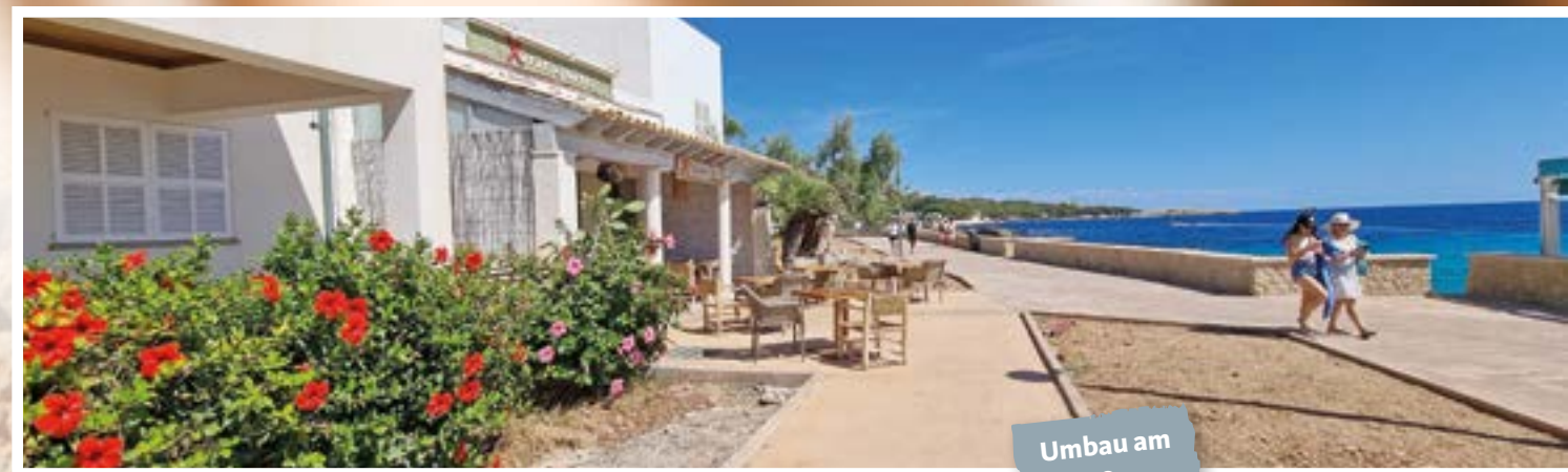
Umbau der Avenida Cala Agulla
